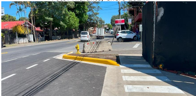
Foto: Hidrante, enero 2024.
