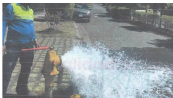
Imagen del estado del hidrante número 5 del residencial Colinas del Viento, 20 de enero 2022.
