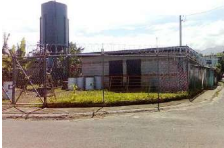
Fotografía 7-4.45. M.ª. Auxiliadora. Tanque de agua ASADA
