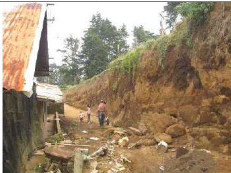
Fotografía 7-4.31. La Esperanza 2. Viviendas ubicadas frente a talud.
