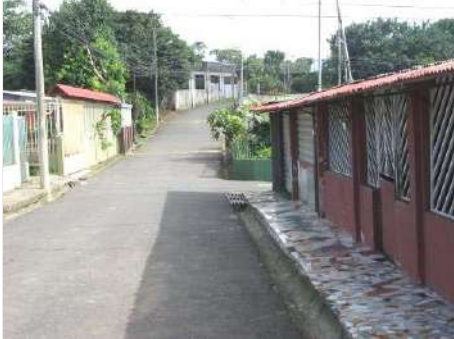
Fotografía 7-4.65. Calle Campos: Infraestructura Vial.
