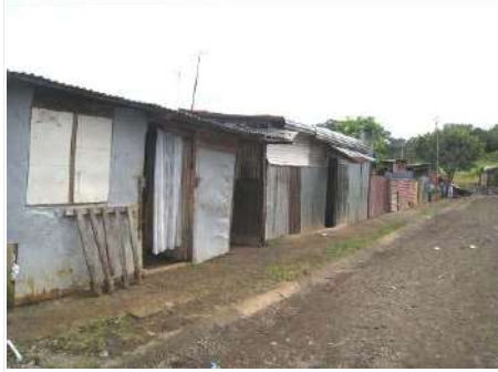
Fotografía 7-4.7. Trópico 2. Falta de infraestructura vial y viviendas adecuadas.
