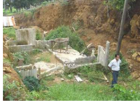
Fotografía 7-4.30. Derrumbe de viviendas debido al terremoto del 8 de enero, 2009.
