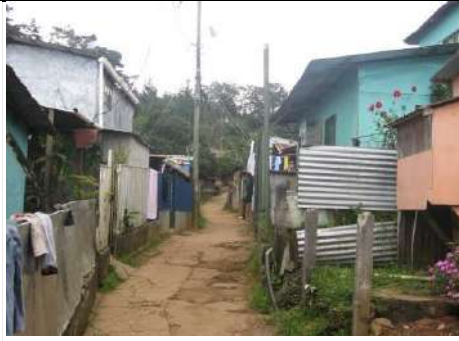
Fotografía 7-4.27. Esperanza 1. Falta de Infraestructura Vial.
