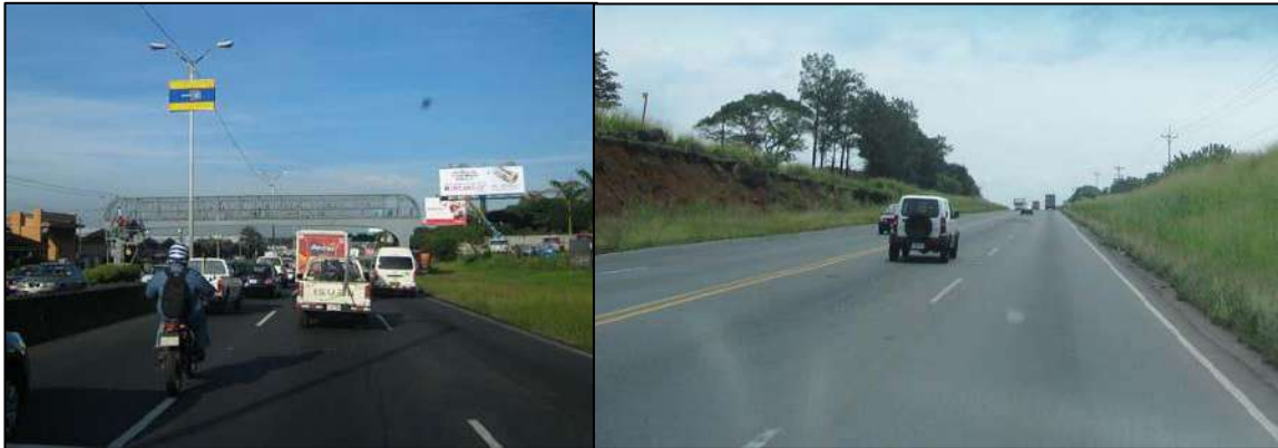
Autopista General Cañas cerca de SARET, b) Autopista Bernardo Soto, El Coyal
