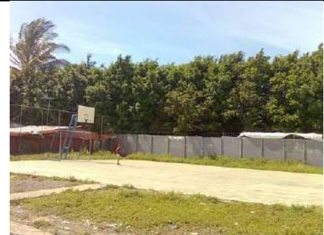
Fotografía 7-4.48. M.ª. Auxiliadora. Área Recreativa en mal estado.
