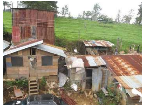
Fotografía 7-4.32. La Esperanza 2. Estado de las viviendas.
