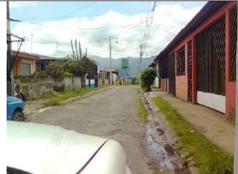
Fotografía 7-4.38. San Gerardo. Aguas servidas por cordón de caño.
