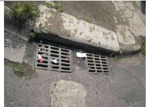
Fotografía 7-4.10. Santa Fe. Alcantarillas.
