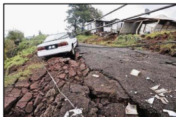
Daños en carreteras y viviendas
